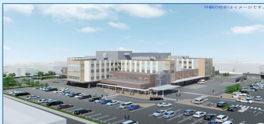
旧北上病院跡地に新設される北上済生会病院は2020年11月に完成予定です。
